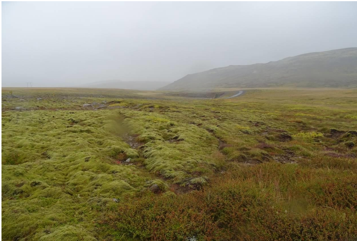
Mynd 34: Gata á Uxahryggjaleið BO-671: 005, horft til NNV. Ljósmynd tók Gylfi Helgason.
